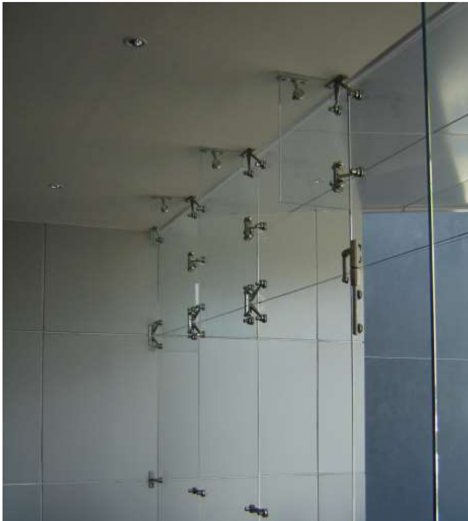
Imagen 1: Fachada de vidrio con Netma Pivot con sistema de arañas.
