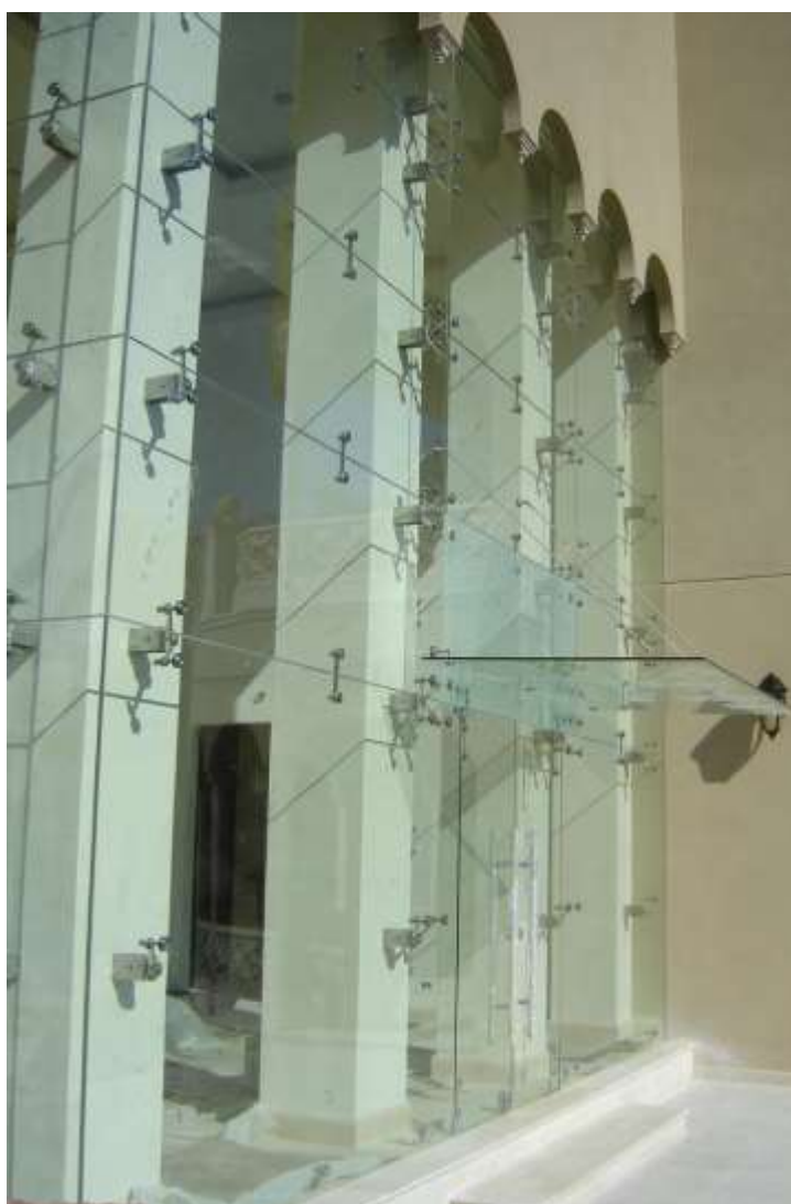
Imagen 1: Fachada de vidrio con Netma Canopy instalado en esta.
